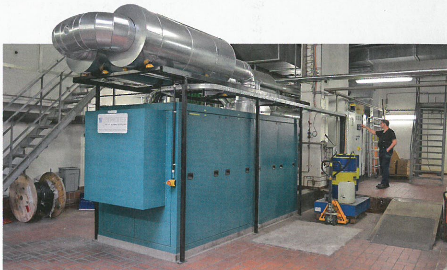
Effizienz-Riese: Das Tippkötter-Blockheizkraftwerk Öko Vario 250 Max besticht durch seinen bisher unerreichten Gesamtwirkungsgrad von bis zu 91,0 Prozent.
